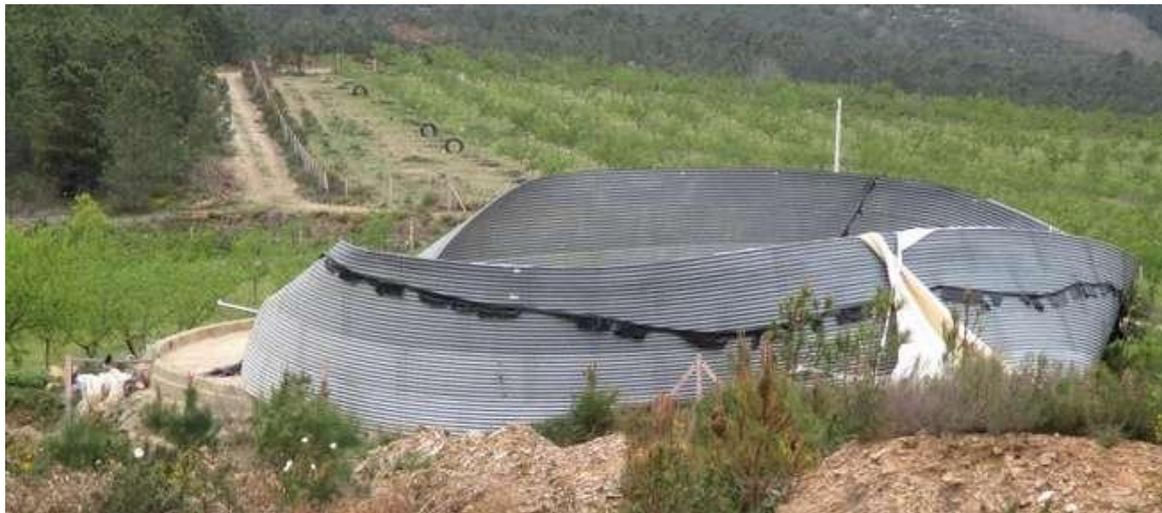
Figura 21. Reservatório de água danificado pelo vento, Castelo Branco – Mogadouro
